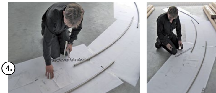
Die Produktionszeichnungen im Maßstab 1:1 gehören zum Lieferumfang, somit haben die Monteure vor Ort eine optimale Übersicht.
